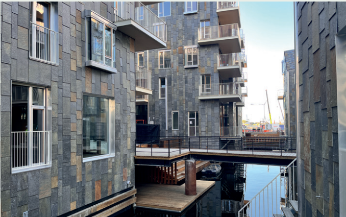
Det er bygd bruer som forbinder punkthusene.
