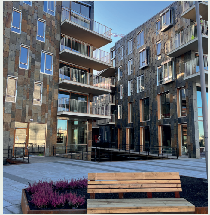
Bebyggelsen ligger rett ved Havnepromenaden i Oslo, og som en del av prosjektet er promenaden blitt utvidet.
